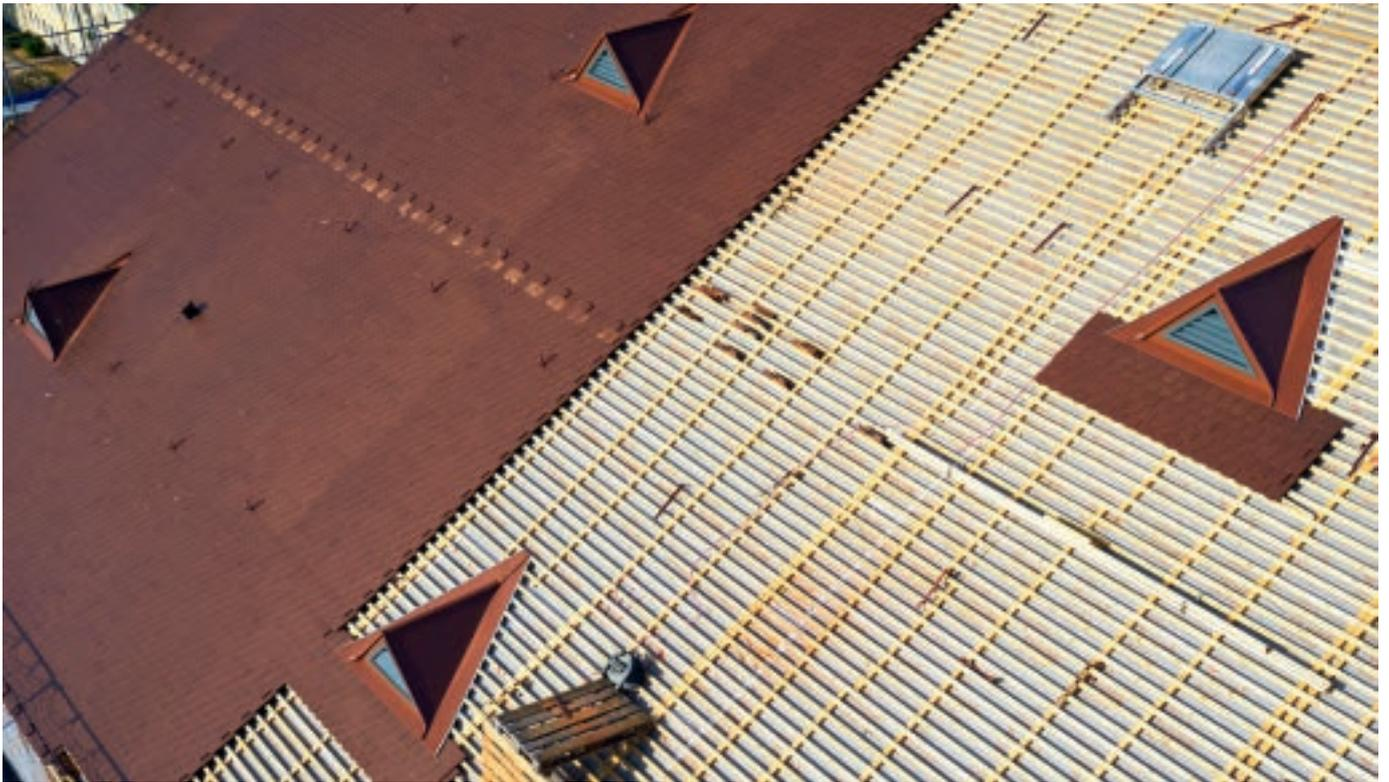
Die Dachdecker mussten 37 Gauben zur Belüftung des Dachraums ersetzen. Diese wurden vorgefertigt und auf die Dachfläche aufgesetzt.
