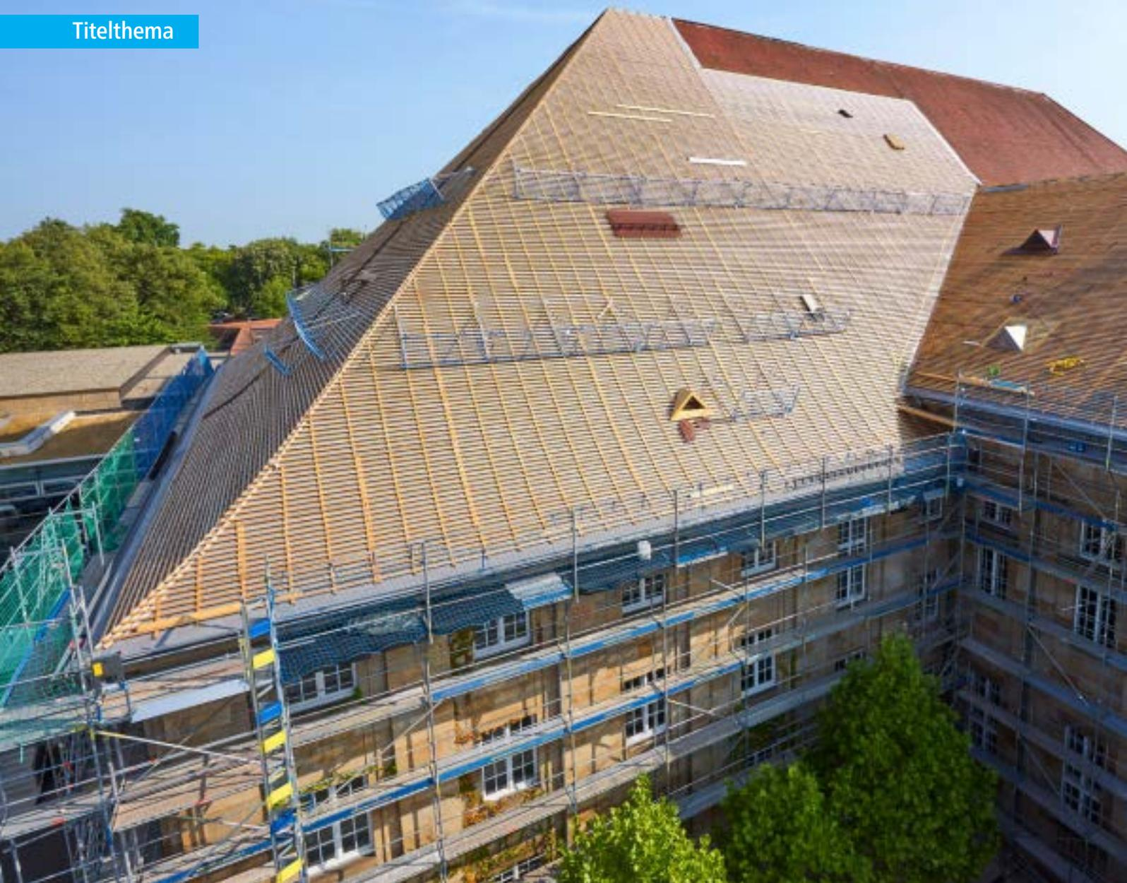
Rund 300.000 Biber zieren zukünftig die Dachflächen des Monumentalbaus in Kassel. Das Unterdach besteht aus einer neuen Vollschalung nebst hochdiffusionsöffener Unterdeckbahn.
