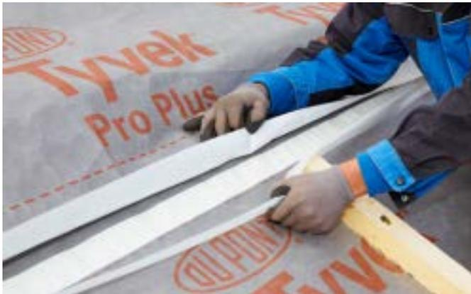
Da die Bahn auf der Rückseite kein Tragvlies benötigt, kann das Kühne-Team die Verklebung an jeder beliebigen Stelle ausführen. Dies ermöglicht ein Verschieben oder Schrägstellen der Bahnen in der Überlappungsverklebung und bringt somit größtmögliche Flexibilität in der Verarbeitung.
