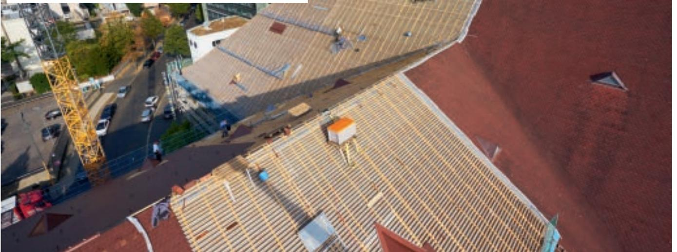
Die Dachflächen wurden in einzelnen Teilabschnitten rekonstruiert. Dabei dient die eingesetzte Unterdeckbahn zunächst als Witterungsschutz bevor die eigentliche Biberschwanzziegeldeckung verlegt wird.
